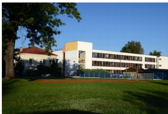
Areál budov Do Nového
